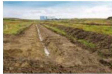
2024 : Ouverture du chantier Débroussaillages, déplacement faune et flore vidange des bassins existants (prise en compte des cycles de vie biologiques)
