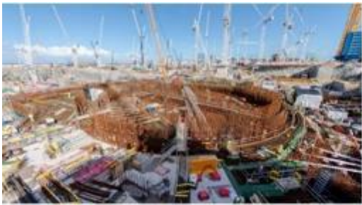
Fin 2027 : 1 er béton de l'ilot nucléaire : JO unité n°1 (2029 pour l'unité n°2)
