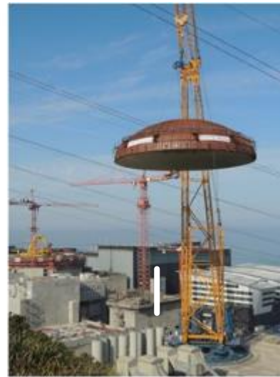
Pose du dôme
