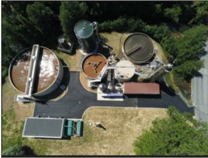
Extension de station avec méthanisation (papeterie)
